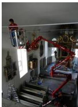
Die Montage wurde, bauseits, von einer Arbeitsbühne aus durchgeführt
