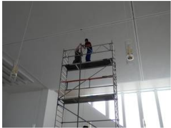
Die Pendelleuchten nach der Montage
